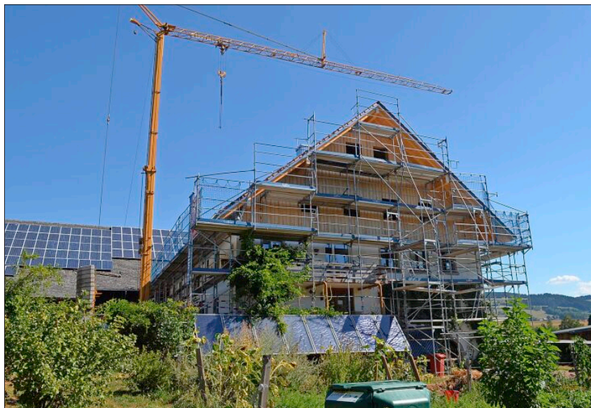
Die Renovierungsarbeiten sind in vollem Gange.
